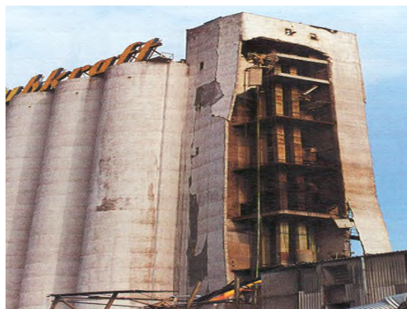
Blikseminslag-stofexplosie-schade
