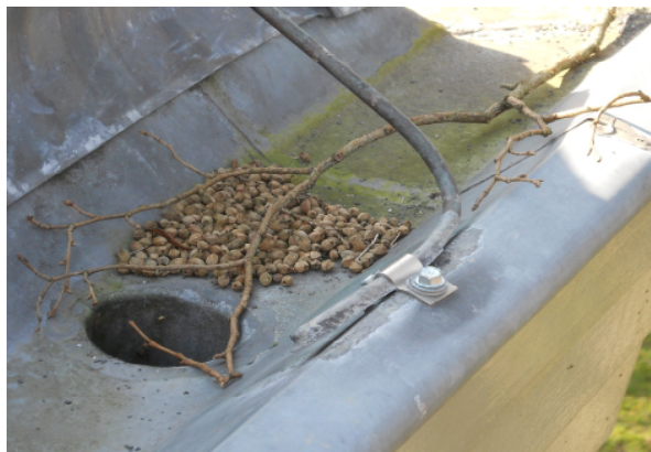
Gootverbinder met overgangsweerstand
